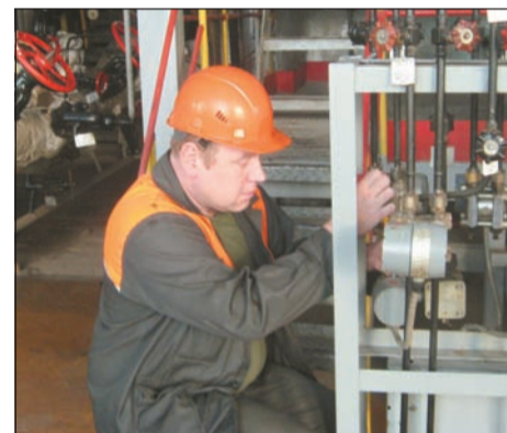
Электрослесарь по ремонту и обслуживанию АСИ С.В. Креленко
